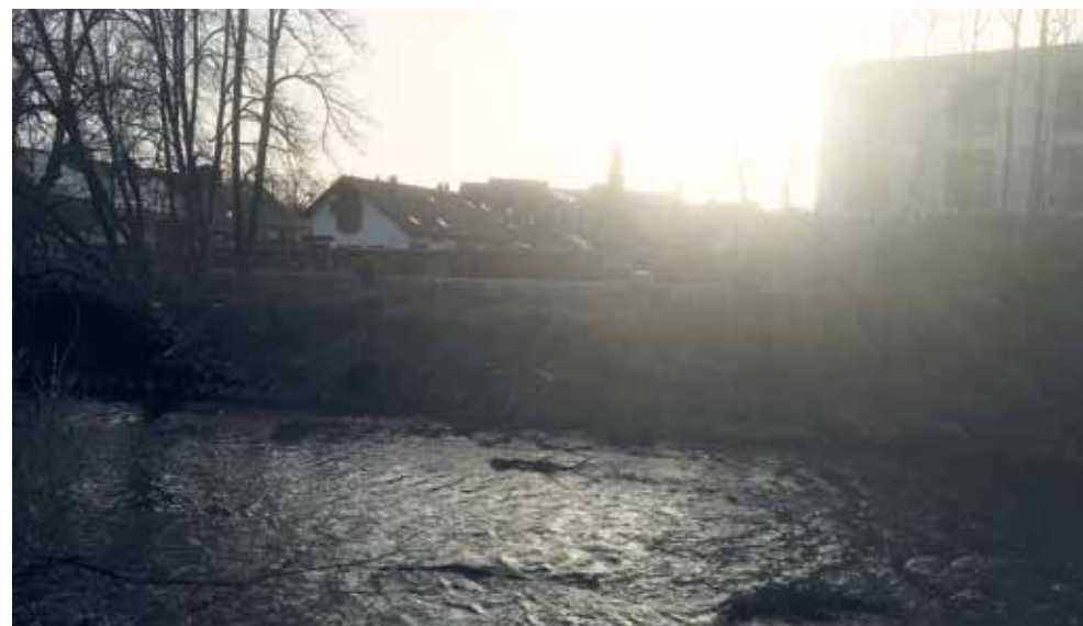
Neuer morgendlicher Blick auf das Pflegeheim über die neue, noch zu bauende, Klösterle-Brücke kommend
