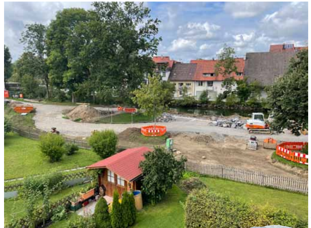
Die Blockhütte im Vordergrund gehört noch zum Kohlerhausgarten. Dahinter die Baustelle an der Argen für den neuen Stadtgarten.
